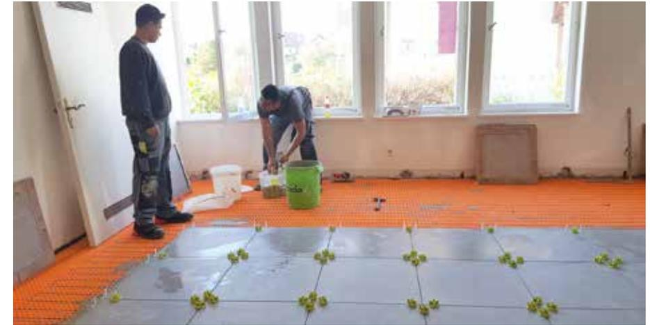
Über der Fußbodenheizung werden die Fliesen im Freiraum von St. Johannes verlegt.
