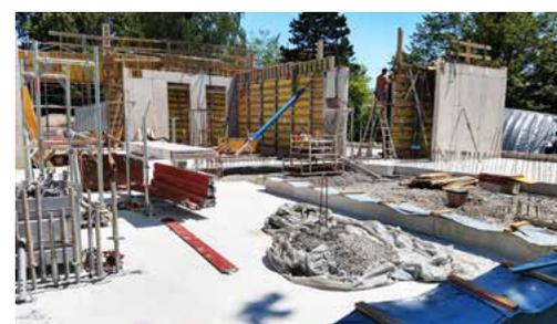
Die Bodenplatte wird betoniert.
